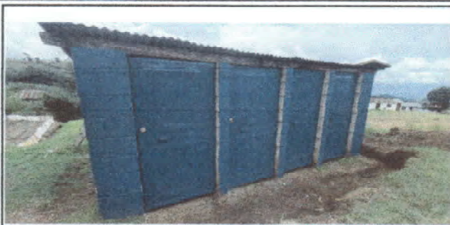
Foto 1: Sustrución de Puertas
