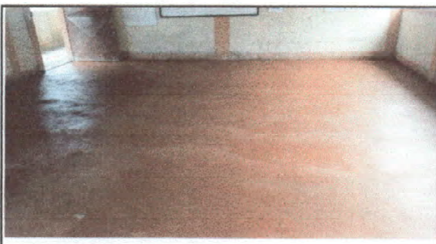
Foto 3: Reparación de piso de torta de concreto
