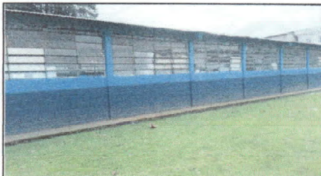
Foto 10: Pintura en muros interiores y exteriores
