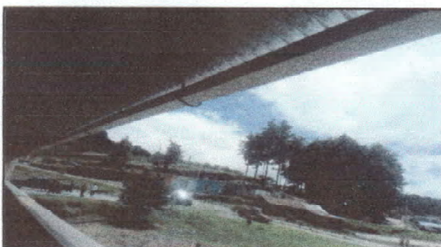
Foto 4: Sustrución de canal de metal
