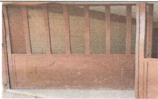
Foto 9: Mantenimiento a portones de metal
