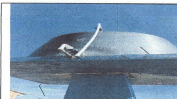
Foto 6: Sustrución de accesorios de depósito de agua
