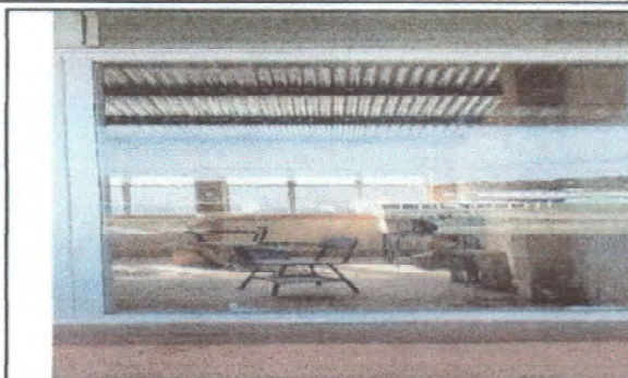
Foto 2: Sustrución de vidrios
